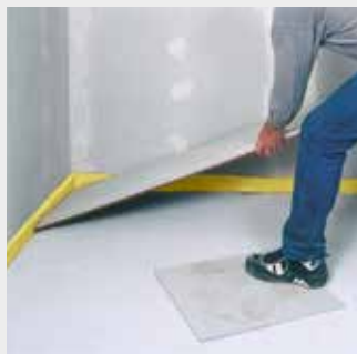
Utläggning av fermacell Fibergips golvelement på fermacell Nivågranulat
