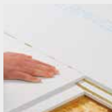
Limning av golvelementen med helt fyllda stödskarvar
