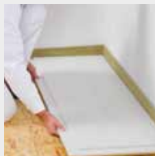
Montering av fermacell Golvelement
