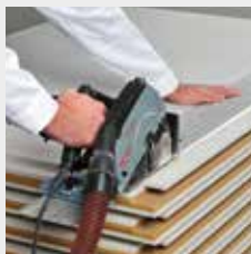
Avsågning av falsen vid första raden
