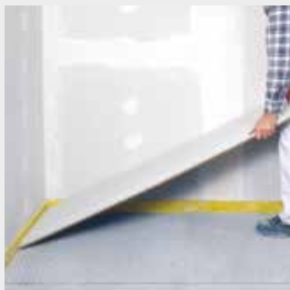
Utläggning av fermacell Fibergips gol-velement
