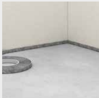
Montering av kantisolering
