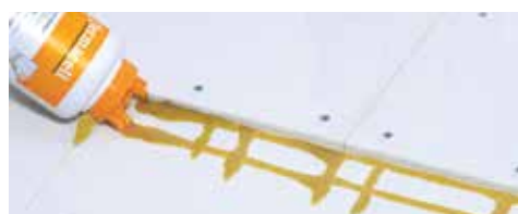
Limsträng på kanten till plattan
