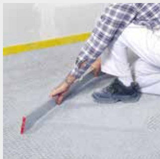
Riktning av fermacell Bikupegranulat
