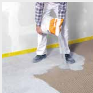
Uthållning av fermacell Bikupegranulat
