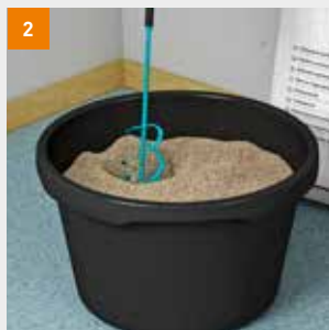
... och vispas tills blandningen har en konsistens som fuktig jord
