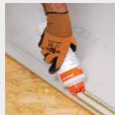
fermacell Fibergips golvelementlim påförs i falsen
