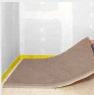
Utläggning av fermacell Bikupeunderlag
