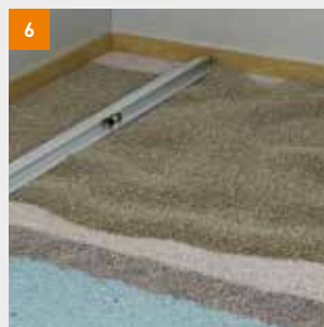
När nivåbruket är lagt mellan banorna avjämns ytan med en fermacell Nivåskena (rätskiva)
