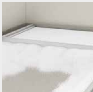
Uthällning och riktning av fermacell Nivågranulat
