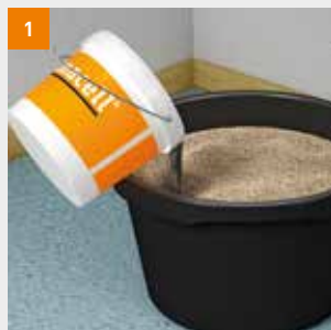
Hela säckens innehåll blandas grundligt med c:a 8-10 liter vatten...
