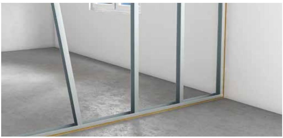
Montering av CW-stålsreglar
